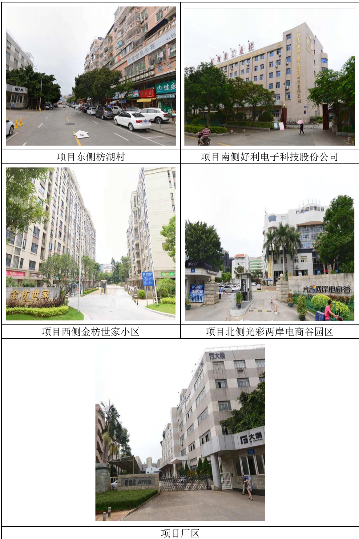
附图 4 项目四周环境现状及项目现状照片
