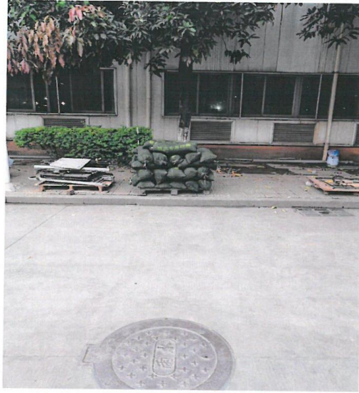
雨水排放口增加封堵措施
